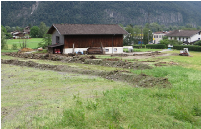
Ablagerungs- und Ausschotterungsbereich beim Lederle: am 08.06.2015 bereits in Sanierung stehend, Behelfsdämme gegen lfd. geschiebelasteten Wassereintrag aus der Hangflanke / Murbahn.
