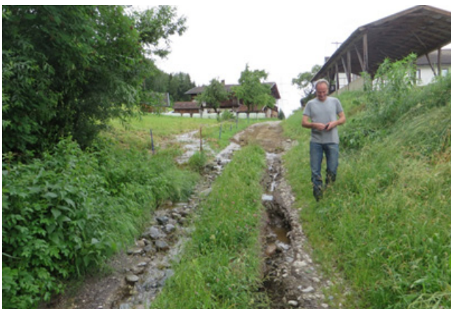
Gemeindeweg Fritzens – Bärfall: überlaufender Schacht mit anschließender Gerinneverlegung und Ausuferung/Erosion im Bereich des Gemeindeweges Fritzens-Bärfall, was in weiterer Folge zur Abdrängung des Vorfluters in der Bärfall mit Ausuferung in den Zufahrtsweg Grill-Roseler geführt hat.
